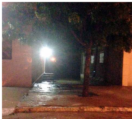
Instalação de luminária em beco escuro ao lado da igreja
